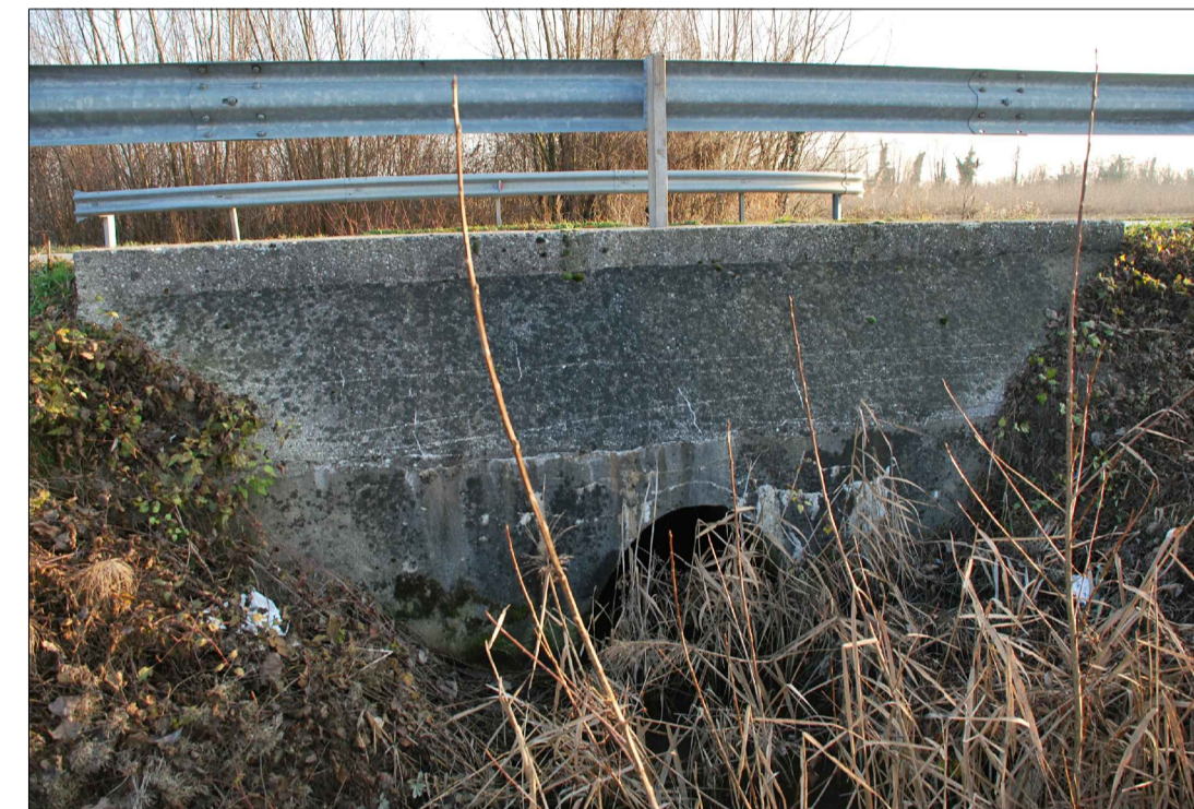
Foto tombotto esistente con tubazione lungo SP93
